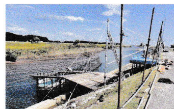
（築場の設置作業）
